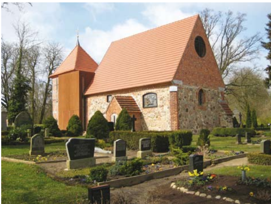
Die Kirche in Barkow (Stadt+Haus Architekten und Ingenieure, Jörn Willert und Markus Weise): Eine gelungene Integration von Moderne und Erbe
